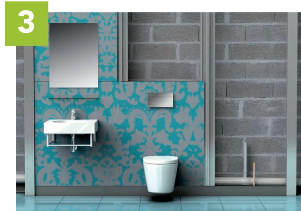
Monter le panneau bas avec son appareillage. Raccorder en eau avec les flexibles.
