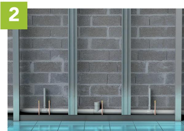
Fixer le rail bas. Puis positionner les montants et le rail haut (une simple clé ALLEN suffit). Raccorder les manchettes PVC aux évacuations.
