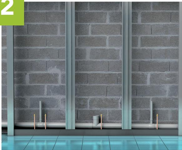
Fixer le rail bas. Puis positionner les montants et le rail haut (une simple clé ALLEN suffit). Raccorder les manchettes PVC aux évacuations.
