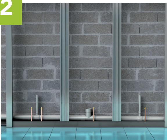
Fixer le rail bas. Puis positionner les montants et le rail haut (une simple clé ALLEN suffit). Raccorder les manchettes PVC aux évacuations.
