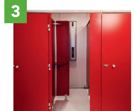
3 Pose des cabines
